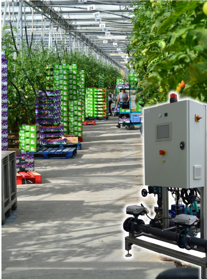
©Eaux de Marseille
